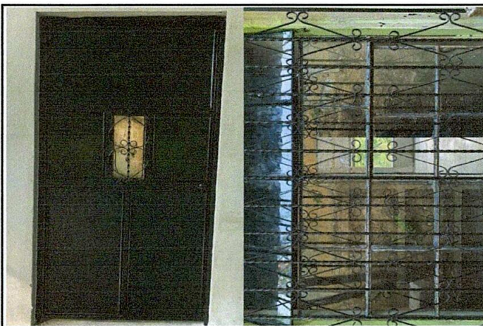
Foto 4: Reparación de dos puertas y dos ventanas en la cocina.
